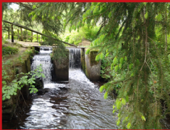
Stauwehr in Eichelhütte
